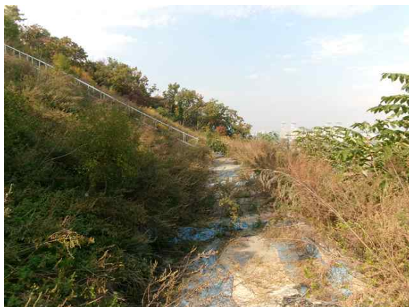
1소단 배수로 전경
