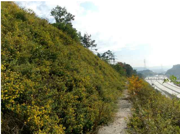
1소단 배수로 전경
