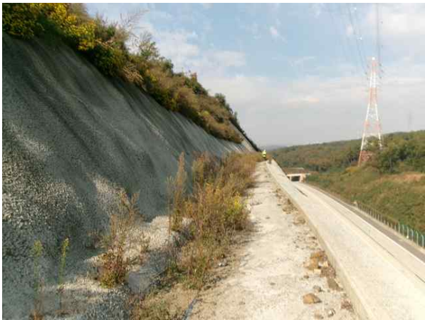
1소단 배수로 전경
